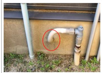
写真 3.2.8 ガス管の貫通部
