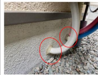
写真 3.2.7 給排水管の貫通部
