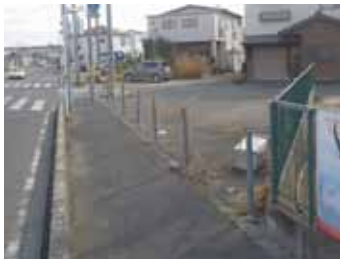
歩道と舗装を合わせて一体的な空間に
