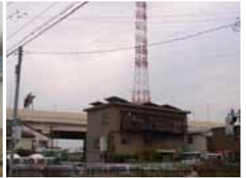
住宅の向こうにも鉄塔
