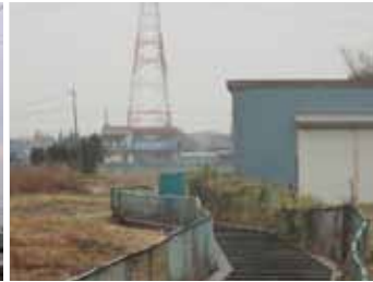
水路の向こうに鉄塔
