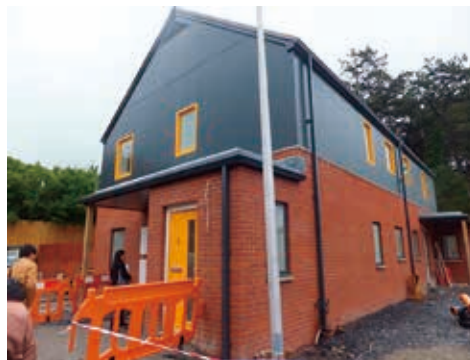
Active Homes Neath 現場
