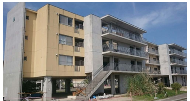
図5. ピロティ構造の事例
