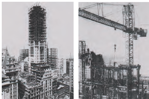
【図1】シンガービルの建設中（左）と取り壊し工事中（右）
