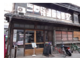
活用後（母屋外観）
