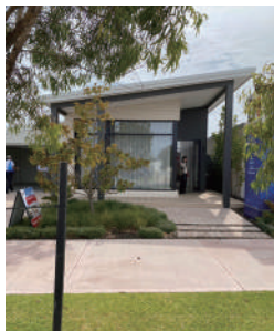
「B1 Homes」の外観
