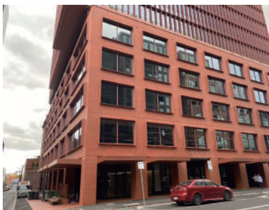
36 Wellington の低層階（RC造）の外観
