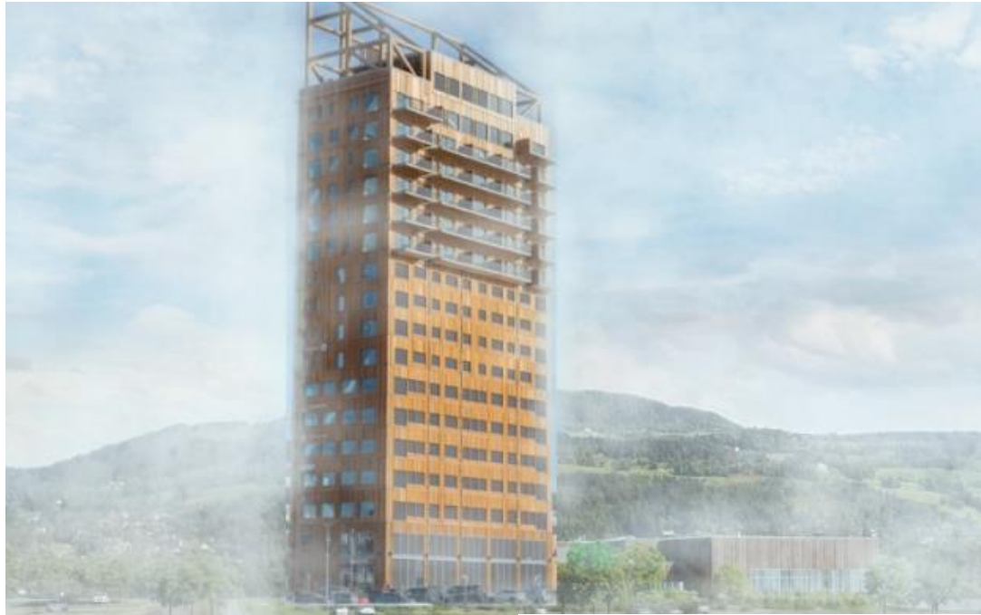
高さ80m超の木造建築:ミョーストルネット / ノルウェー
