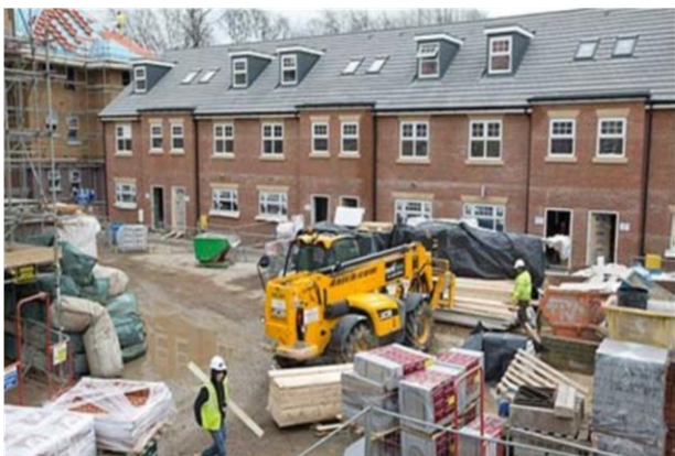
住宅建設現場 / ウェールズ
