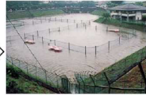
雨水貯留浸透施設の例(防災調整池)
