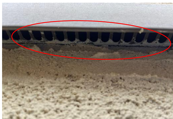
写真 3.2.5 基礎上の床下換気口
