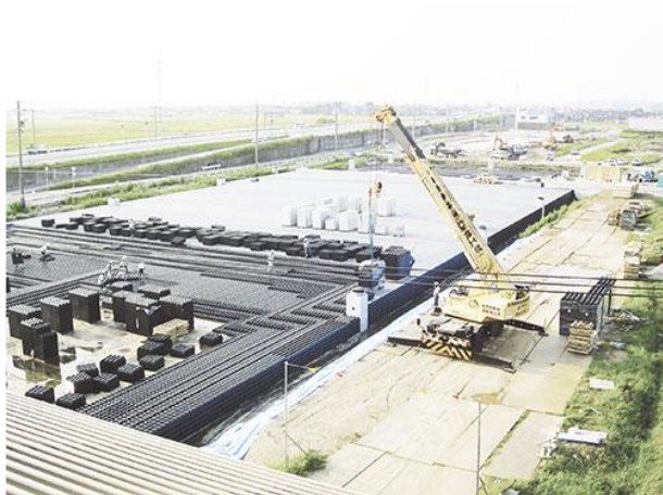
プラスチック雨水浸透槽「クロスウェーブ」
