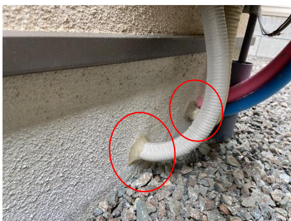
写真 3.2.7 給排水管の貫通部
