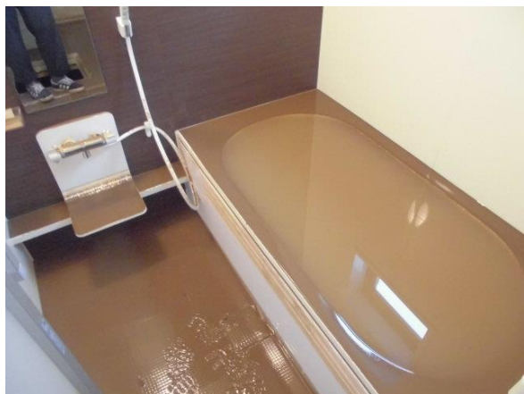
写真 3.2.15 設備・排水管
