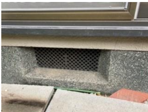
写真 3.2.1 基礎の床下換気口
