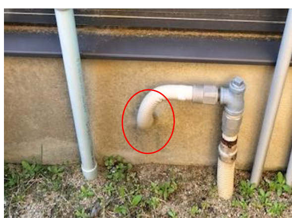
写真 3.2.8 ガス管の貫通部
