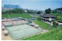
雨水貯留浸透施設の例(防災調整池)
