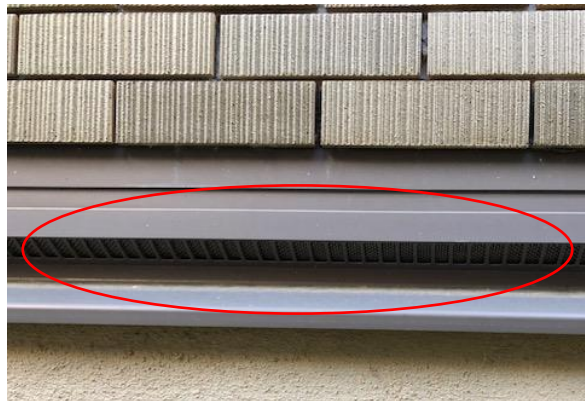
写真 3.2.6 基礎水切りの床下換気口
