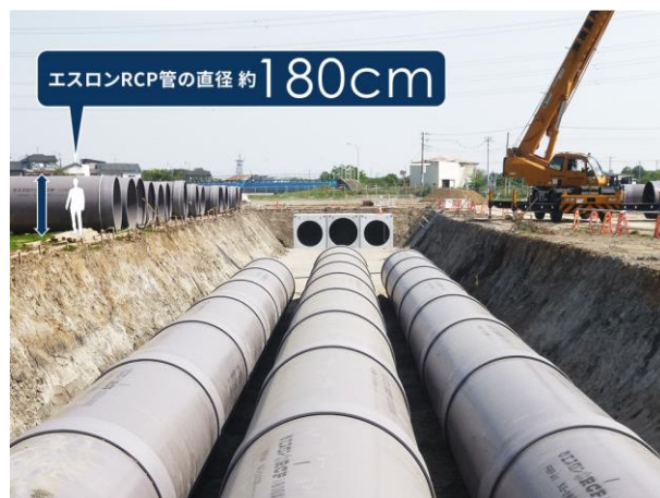
大口径強化プラスチック複合管「エスロン RCP」
