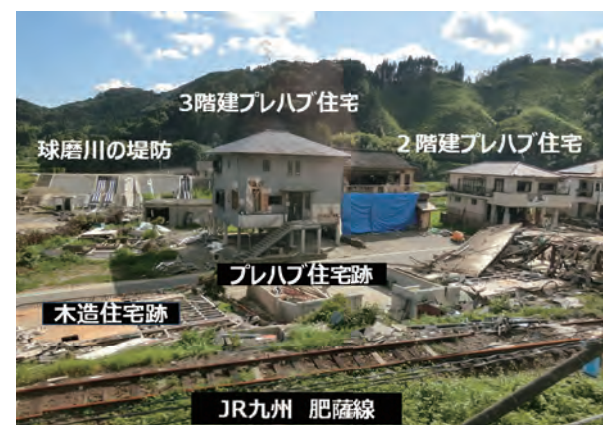
【図 5】人吉市の被災住宅地
