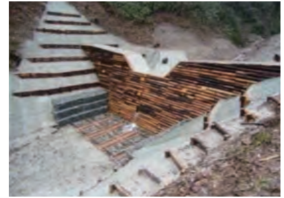
間伐材型枠を使用した治山ダム
