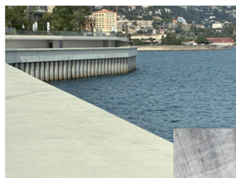
▲【上】ケーソン外観
